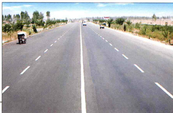
宽阔整洁的107国道沥青路面
