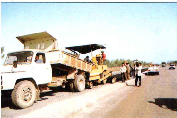
沥青摊铺机正在封层作业
