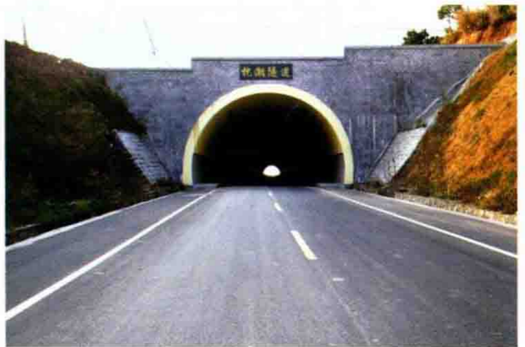
■ 枕头山至潮头门公路隧道
