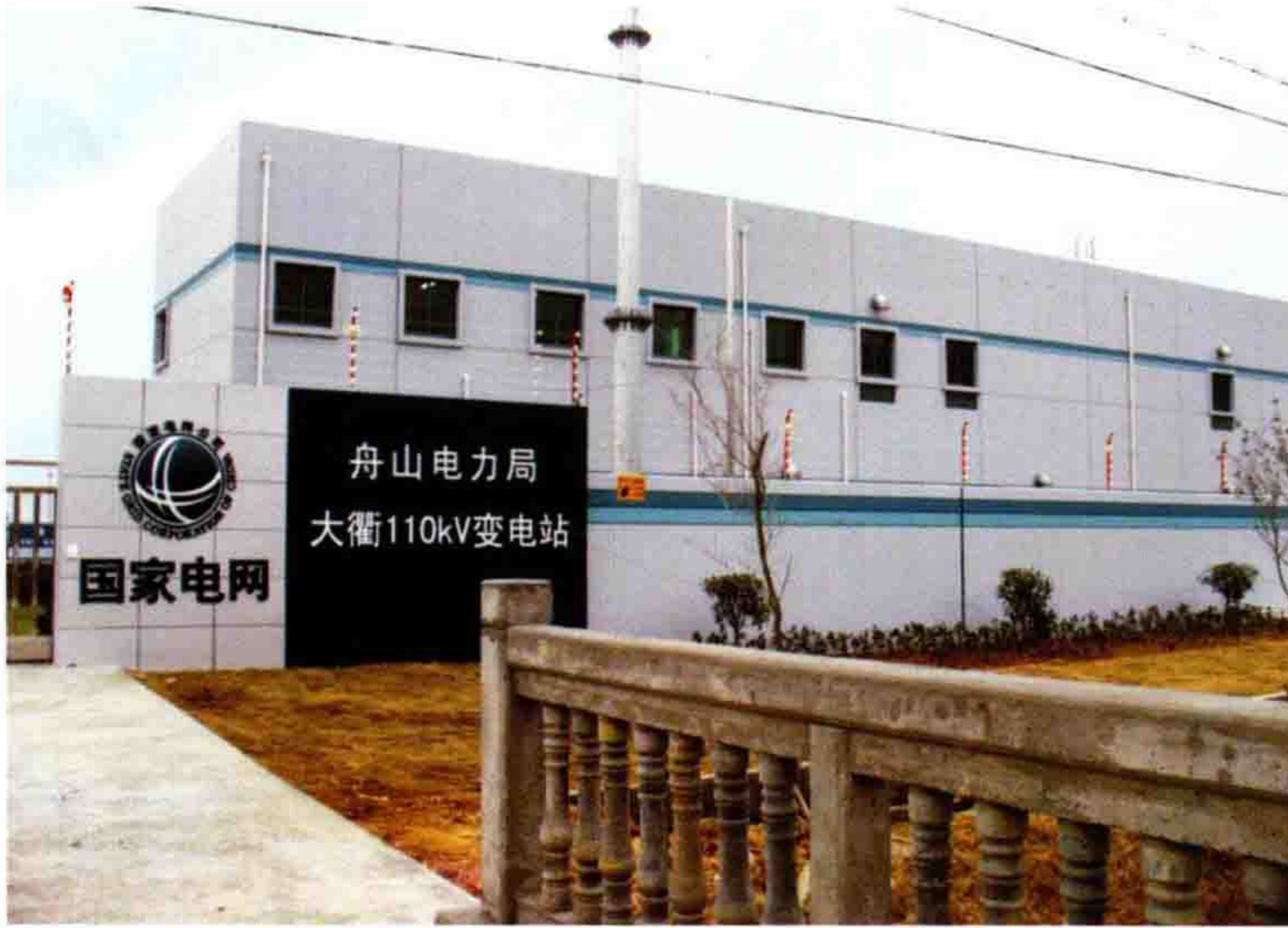
■ 110 千伏大衢输变电工程投运
