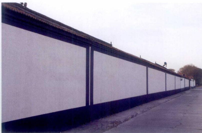
延庆县康庄镇火烧营村抗震节能工程——墙体保温
