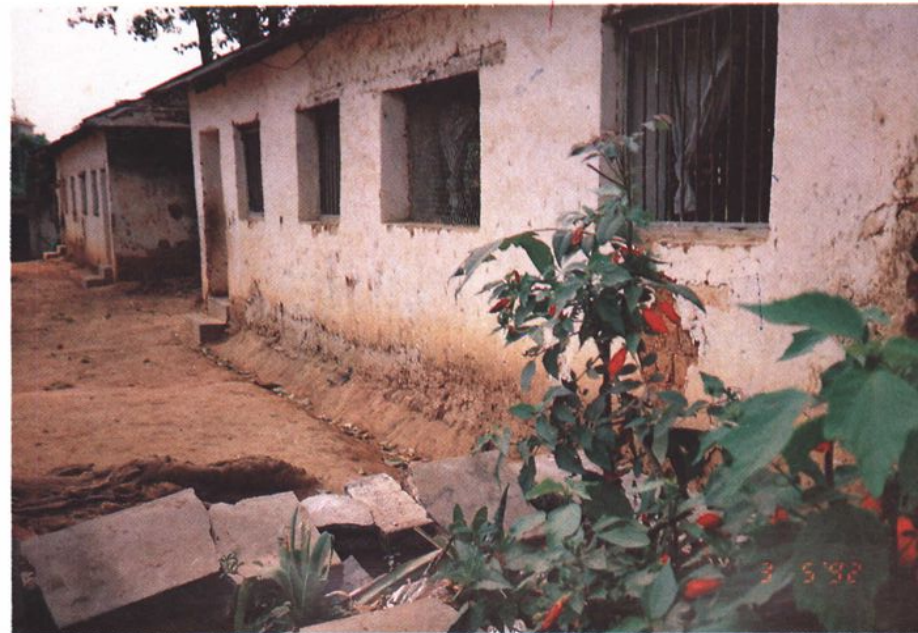
芒市一小校内土司统治时期建盖的校舍
