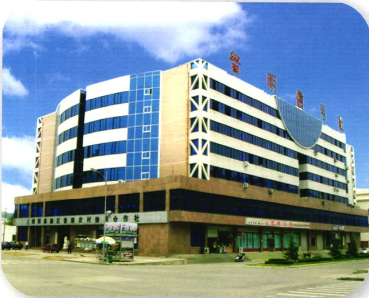
普明信用社新建的综合楼
