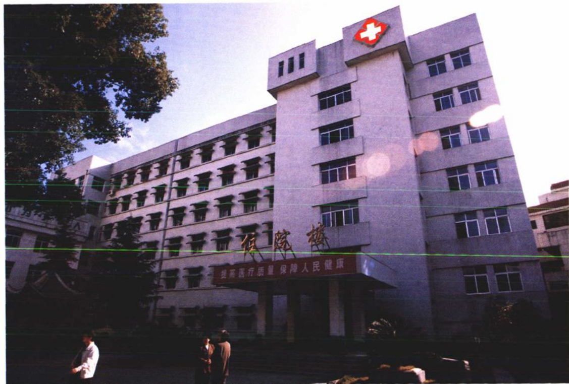
住院大楼（1991年1月落成）
