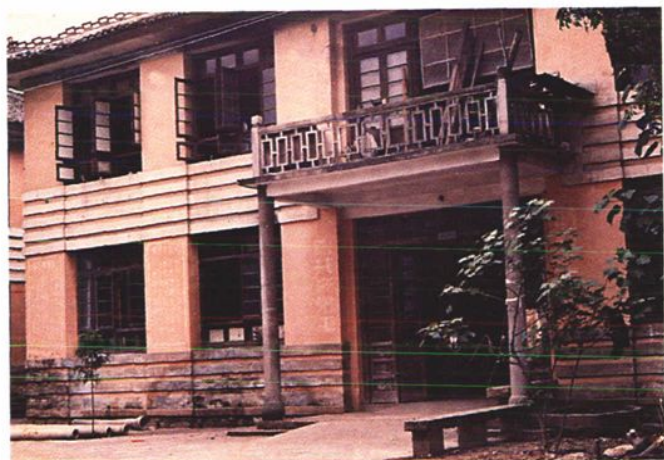
1953年建的门诊楼
