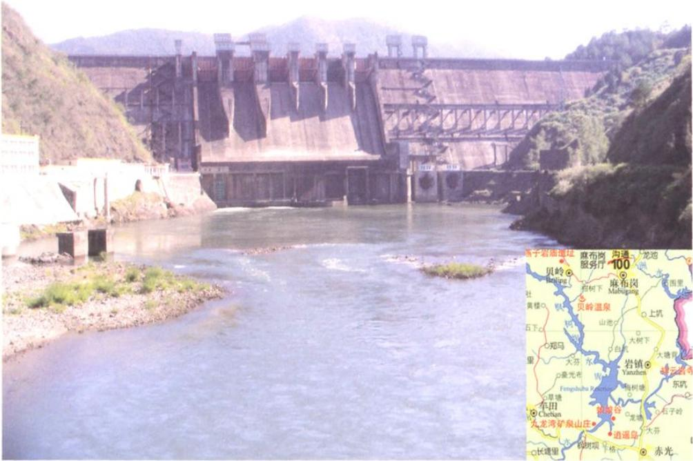
枫树坝水电站地处龙川县枫树坝镇。于1970年8月1日动工，1974年11月29日竣工，装机2台，总容量为16万千瓦，年设计发电量5.76亿千瓦时。集雨面积5150平方公里，最大库容19.32亿立方米，淹没龙川、和平、兴宁等地10个公社32个大队，移民人口18735人。
