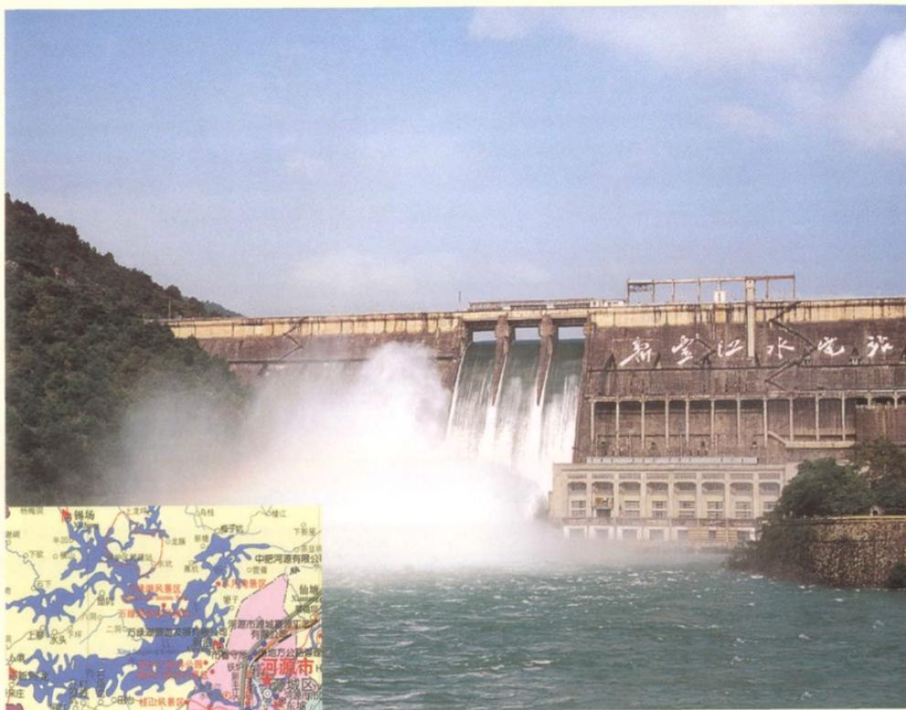
新丰江水电站位于河源市区西6公里处的双下村。于1958年7月15日动工，1960年发电，装机4台，总容量为29.25万千瓦，年设计发电量10.68亿千瓦时。水库集雨面积5740平方公里，最大库容139亿立方米，淹没面积600平方公里，涉及河源、连平、新丰等县16个圩镇，389个村庄，移民人口10.64万人。
