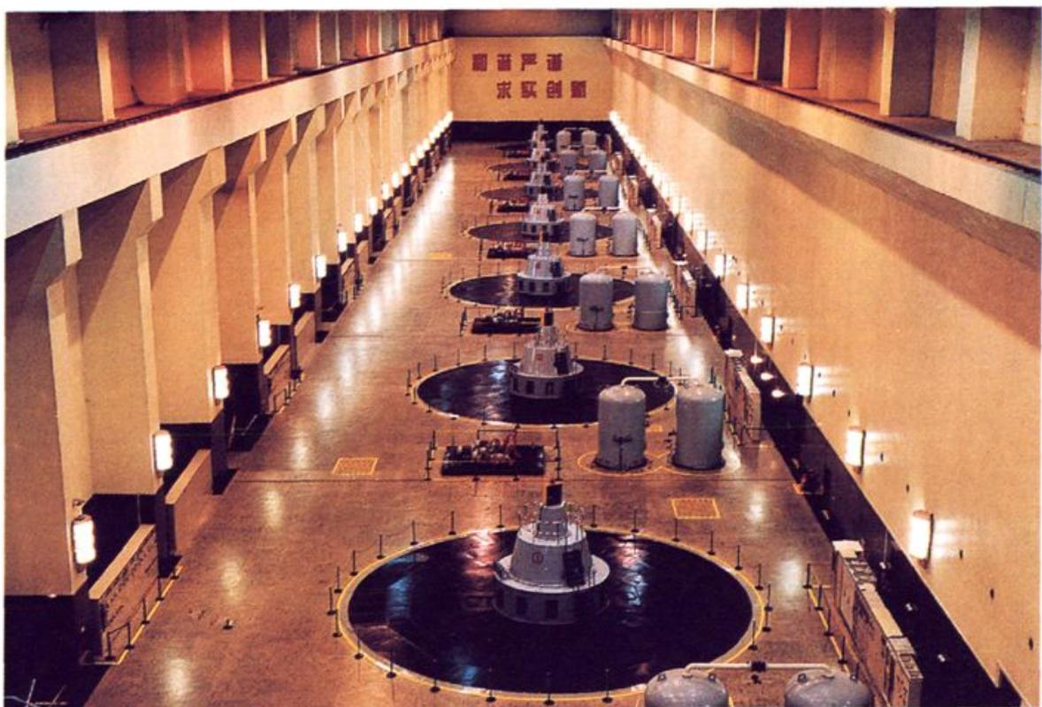
水口水电厂水轮发电机组
