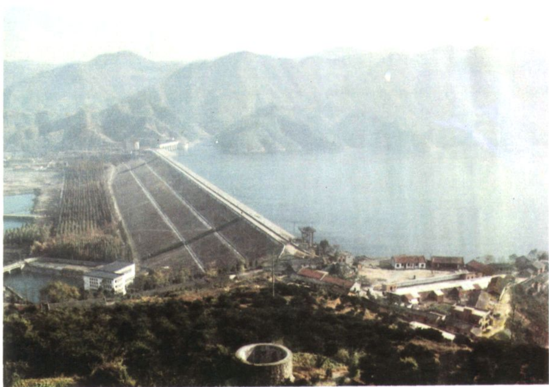
富水水库大坝
