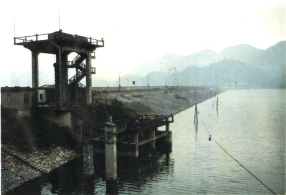
发电输水管进水闸
