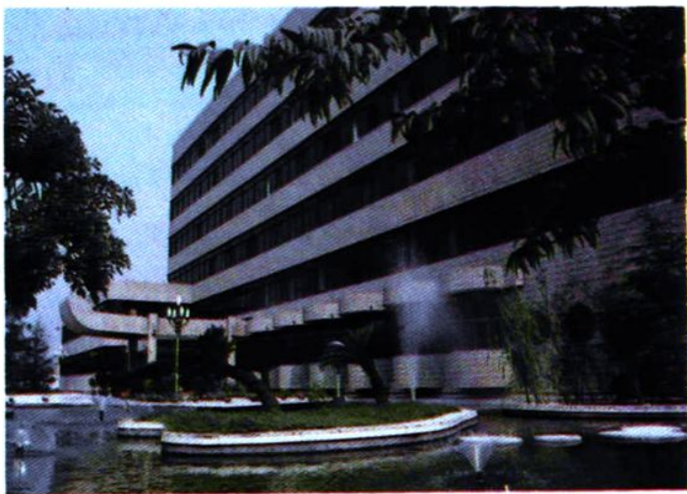
民航科研二所科研大楼
