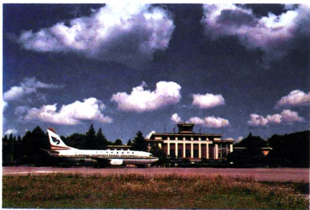
贵阳磊庄机场候机楼
