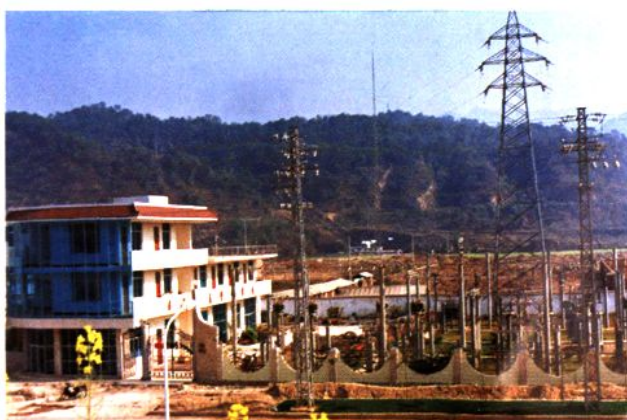
城区中心变电站
