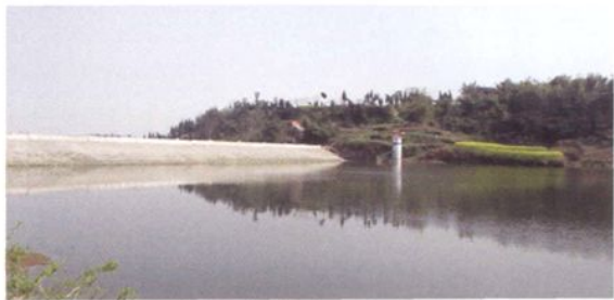
枢纽完备的渠县小（一）型九龙水库
