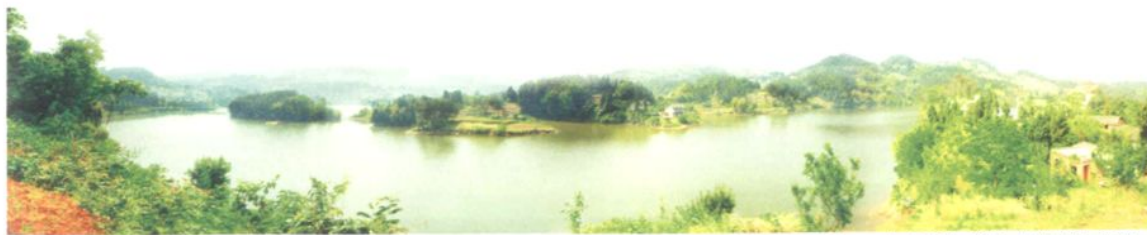
达州最早建成的“老水库”达县中型明星水库
