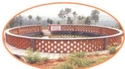
达县小微水蓄水工程
