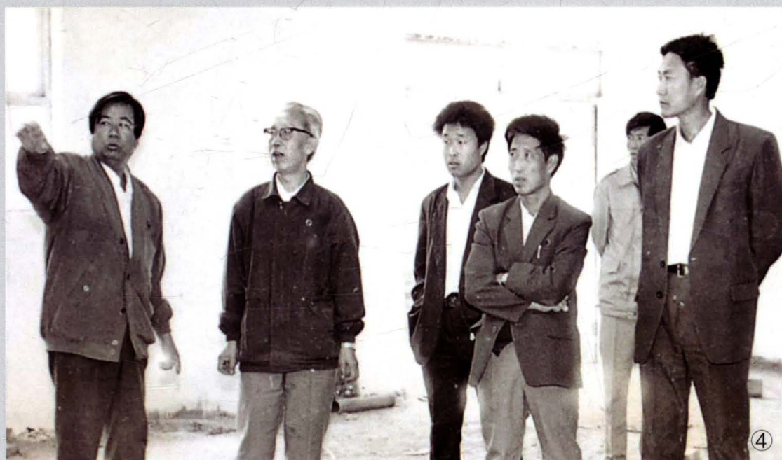
④ 1995年，肖秋生等领导班子在消毒剂技改施工现场
