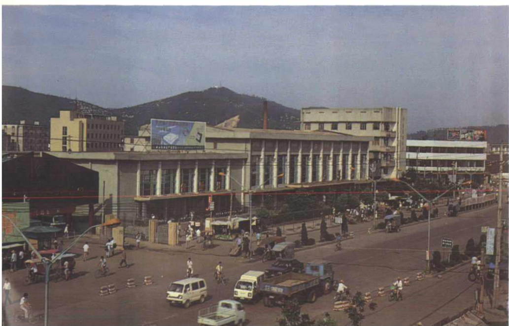
上：城区国道 329国道横贯全境， 城区段宽40米。 中：国道夜景 下：慈溪客运站
