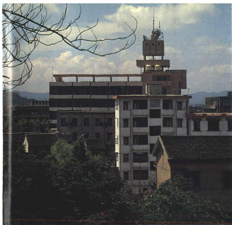
上：电信大楼（1990年） 万门程控电话控制中心。 中：四灶浦大桥 西新公路桥，单跨42米。 下：范市变电站 东部地区电力输入点（35千伏）。
