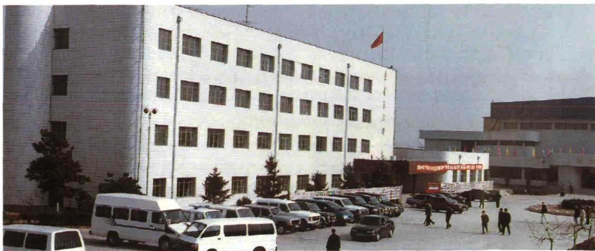
22. 绥中现场东电三公司办公楼
