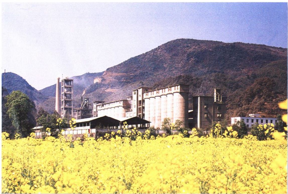
习谦水泥厂——深山峡谷中一道靓丽的风景线
