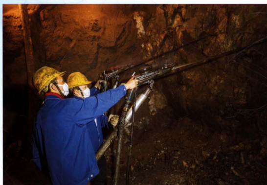
井下打钻作业
