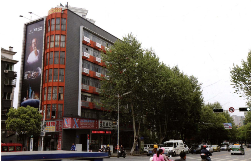
1986年，市冶金公司自筹资金建成冶金大楼，是当时市区东门外第一栋全框架7层大楼，几十年来成为市区改革开放和城市建设大发展的标志性建筑。图为冶金大楼一角
