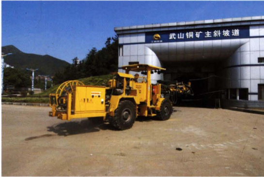
武山铜矿主斜坡道
