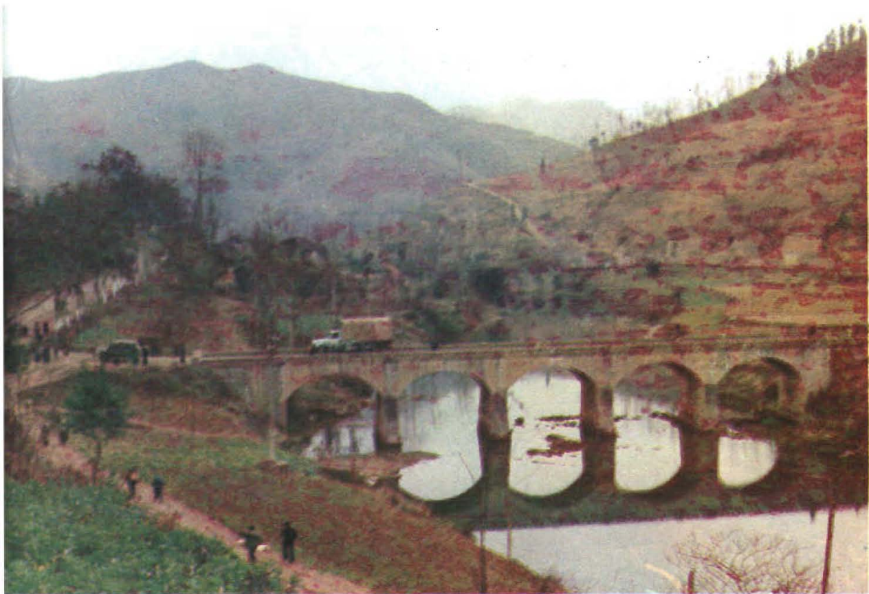
横跨在贵（阳）紫（云）公路上的座马河大桥
