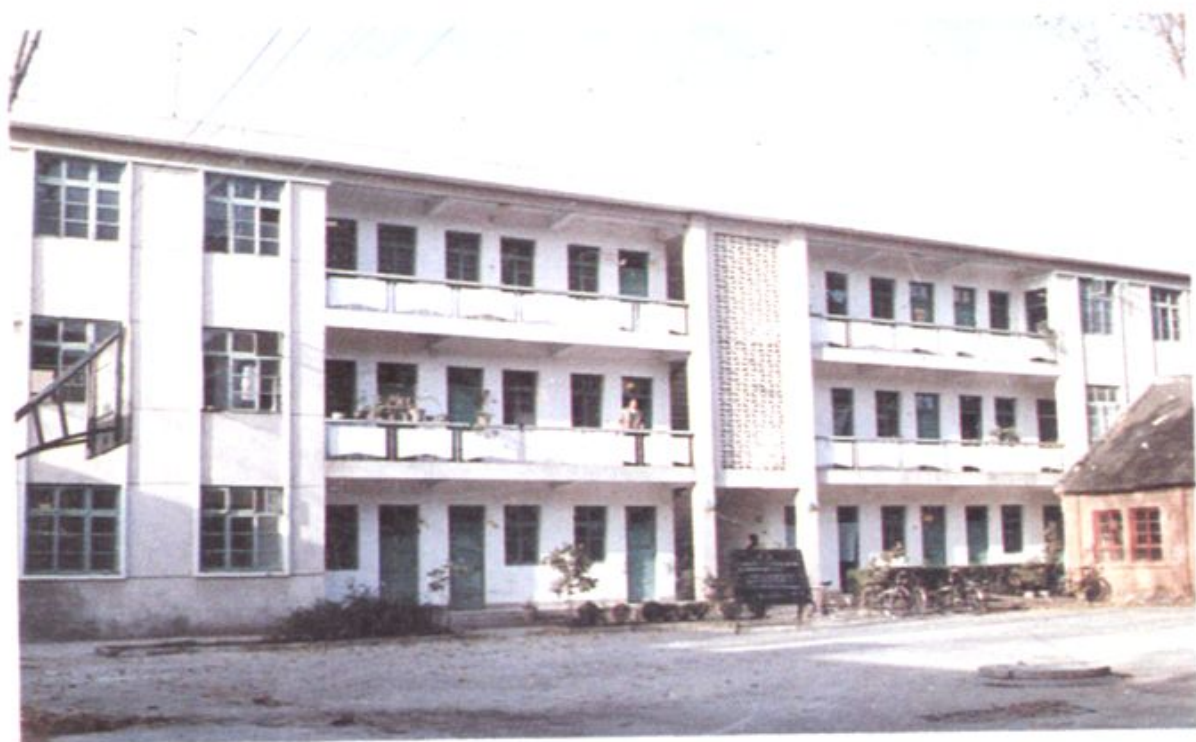
二、粮食局二号办公楼
