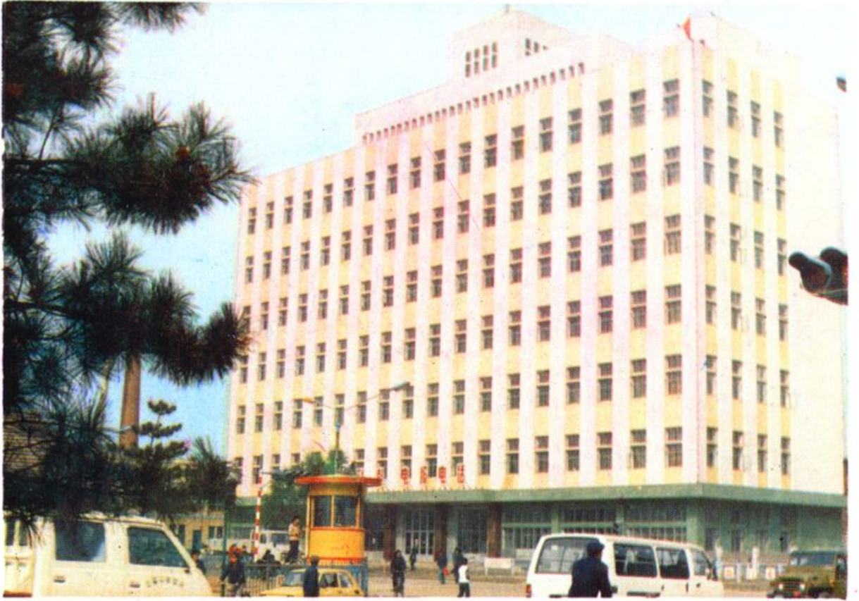
延吉市电报电话大楼
