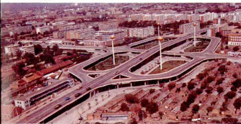
▲ 八里台立交桥
