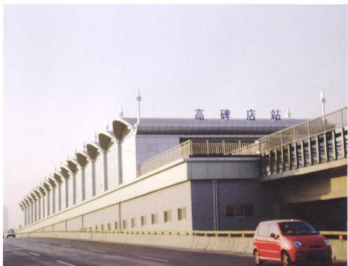
北京地铁八号线高碑店车站
