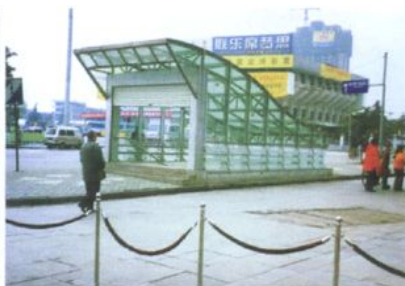
武汉中山广场地下过街通道
