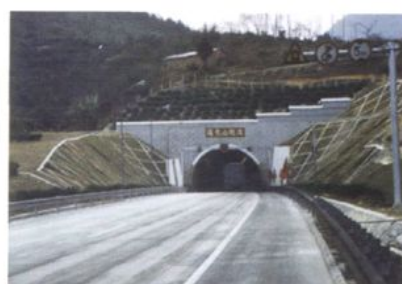
广汕揭梅高速公路莲花山隧道
