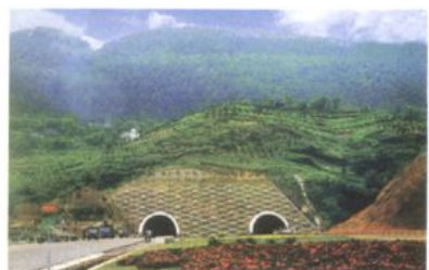
渝合高速公路北碚隧道
