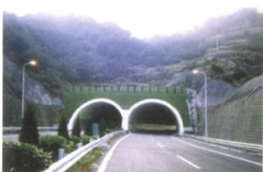
金丽温高速公路双港桥隧道
