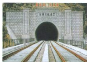
朔黄铁路寺铺尖隧道
