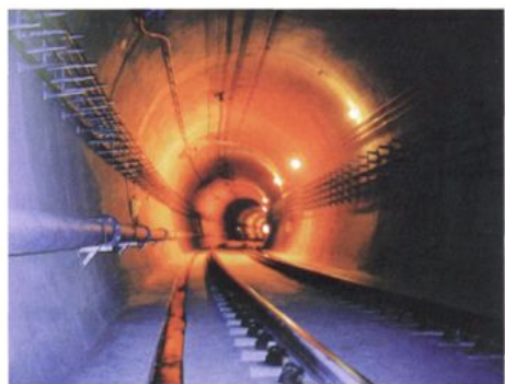
广州地铁一号线杨体区间
