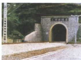
株六复线大竹林隧道
