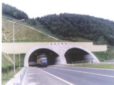
京珠高速公路五龙岭隧道
