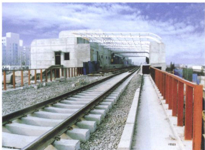
北京快速铁路轨道工程 04 标西二旗车站
