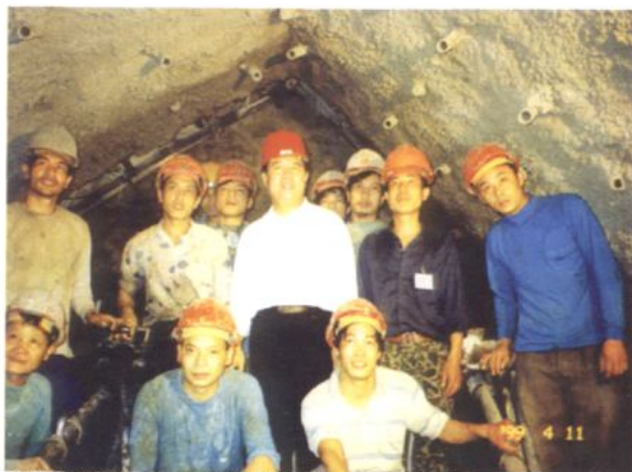
铁道部部长傅志寰同志视察内昆铁路曾家坪一号隧道
