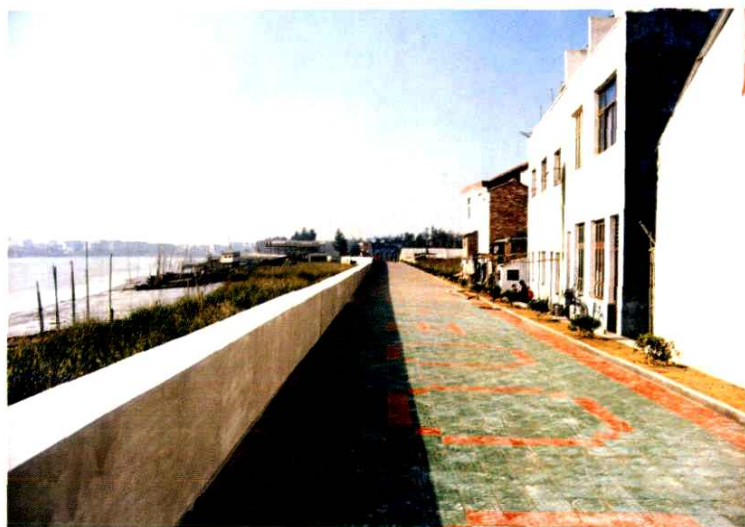
重力式结构的鳌江镇区段标准堤
