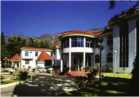
县相岭冶金炉料公司办公区
