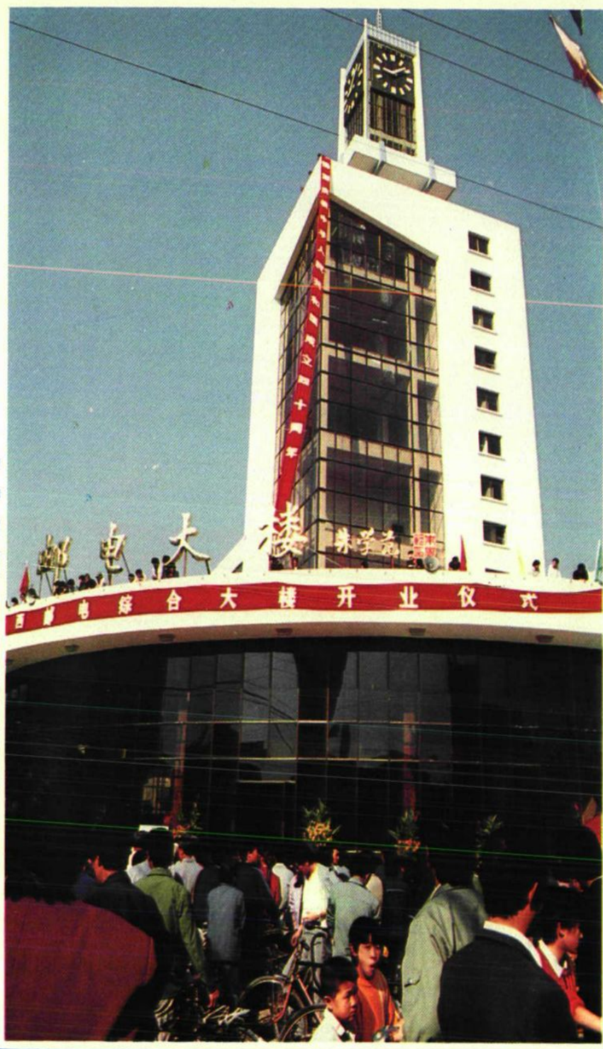
●●● 新建莱西邮电大楼
