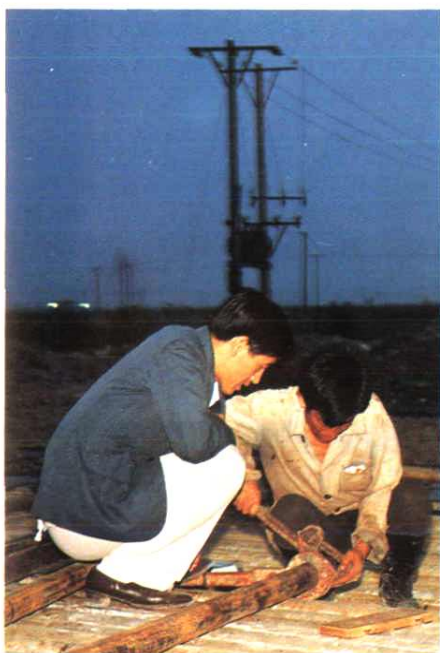
◀公司副经理郭洪吉(左一)在施工现场
