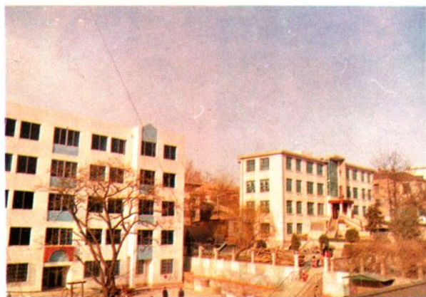
幼儿园新建教学楼
