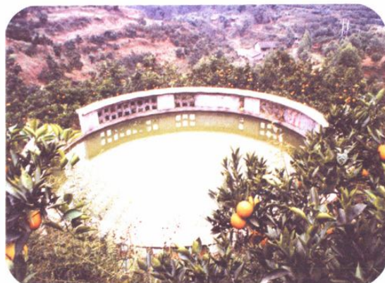
县集雨节灌工程示范片——长秋乡微型水利工程蓄水池
