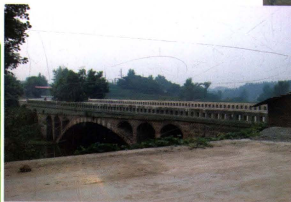
1995年改建后的长滩河大桥 (拍摄时间: 2008年6月)
