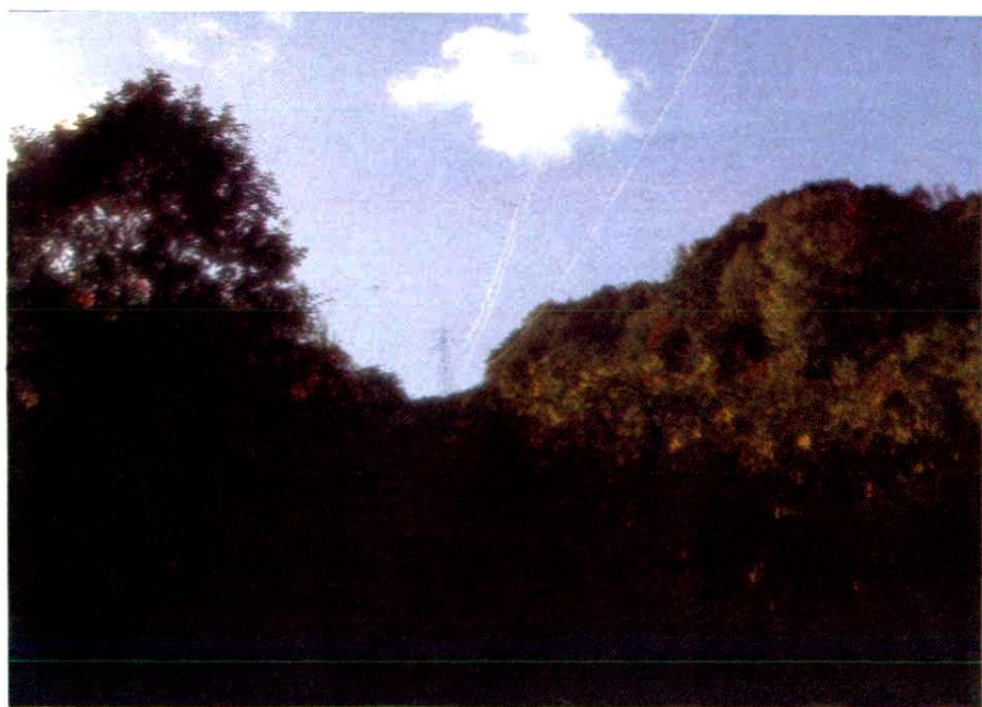
穿过林海的高 压输电线路
