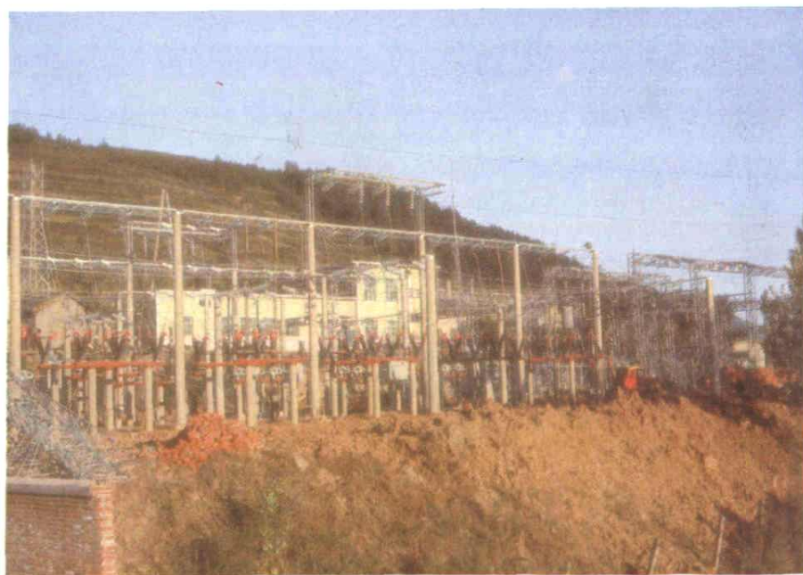
安全运行10,000天的 临江变电所正在扩建中
