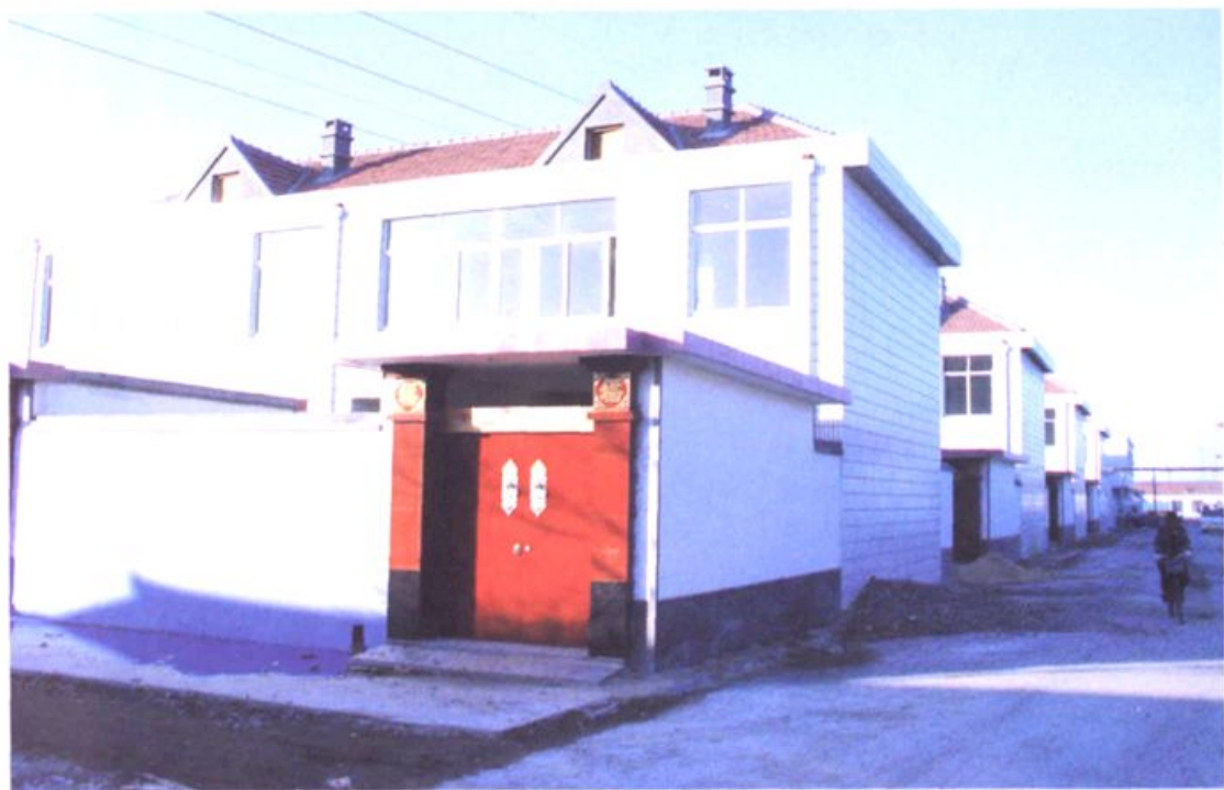
图为官曲村村民公寓楼区的一角
