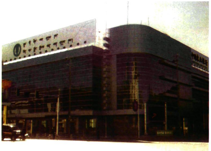
中国农业银行西藏 自治区分行办公大楼
