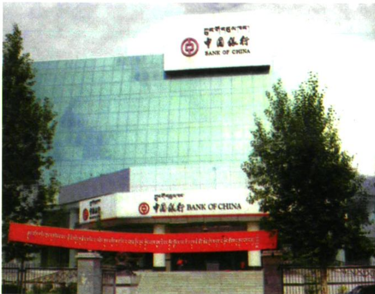
中国银行西藏自治区 分行办公大楼
