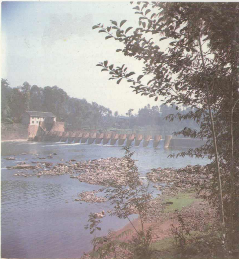
图为渠首。 花溪渠是洪雅县最大的灌溉渠之一。
