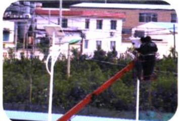
安装太阳能路灯
