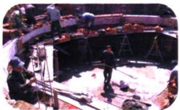
沼气池在施工中
