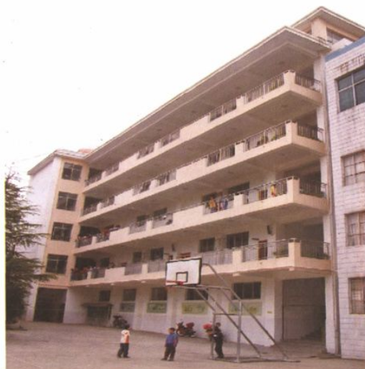
2004年新建教学综合楼
