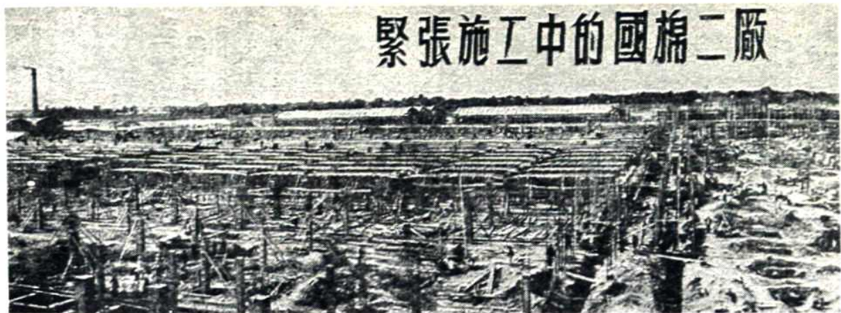
6. 1954年5月紧张施工中的石家庄二棉
