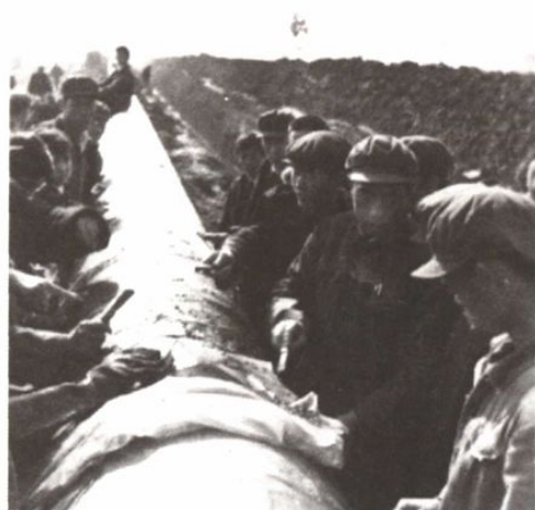
1973 年张文义、邢振亚检查大庆—铁岭工地
