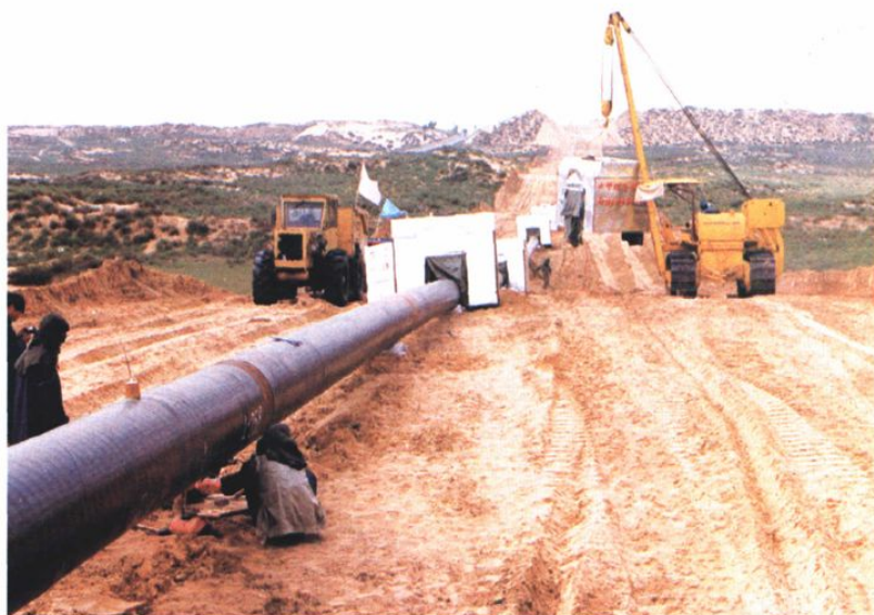
长输管线焊接工艺
