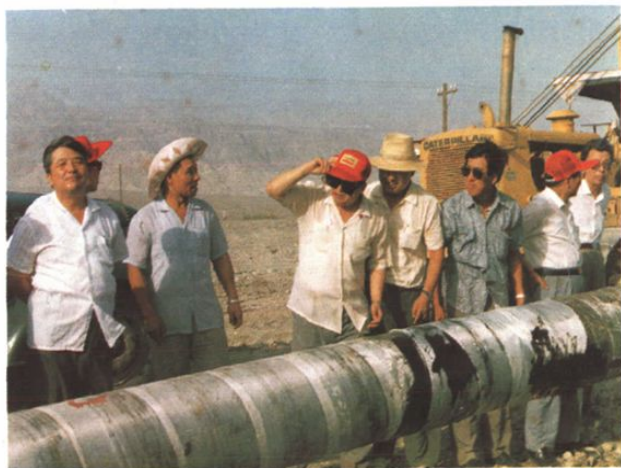
王涛总经理深入新疆沙漠施工现场检查工地
