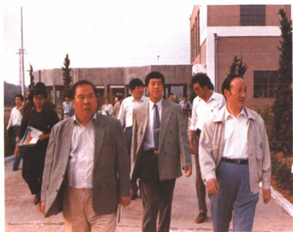
建设部副部长李振东同志视察管道二公司徐州污水处理厂工地
