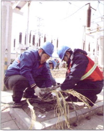
罗义变电站春检现场
