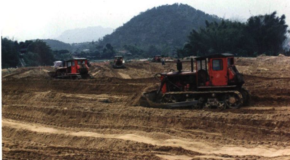
容县杨梅镇六美村高架 垌耕地开垦现场。
