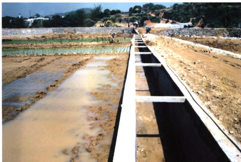
2002年4月，杨梅镇六美村高架垌耕地开垦项目竣工，图为新开垦的耕地。
