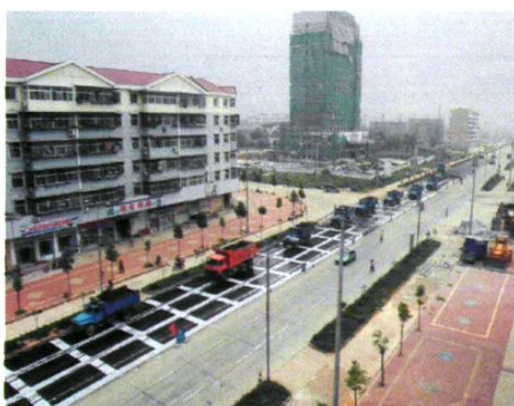
▲城区沥青路铺设现场
