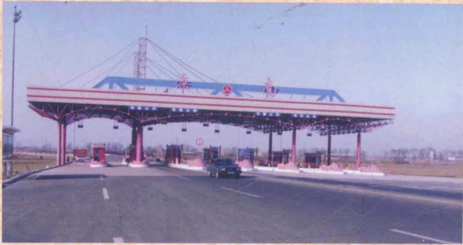
◀ 唐(山)(京唐)港高速公路滦南出口
