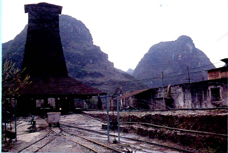
○ 泗顶矿区南矿竖井外景。
