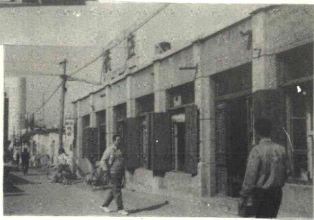
秦皇岛药材站百草堂药房 (原东鲁药房, 始建于 1920 年)→
