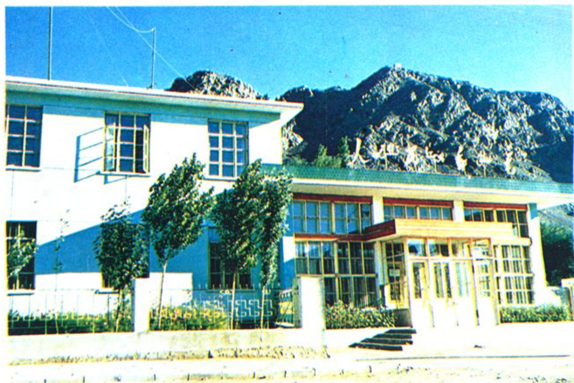
8、1985 年建成的伊吾县邮电局
