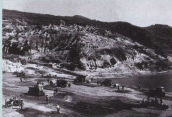
1974年大 棚子水库施工现场
