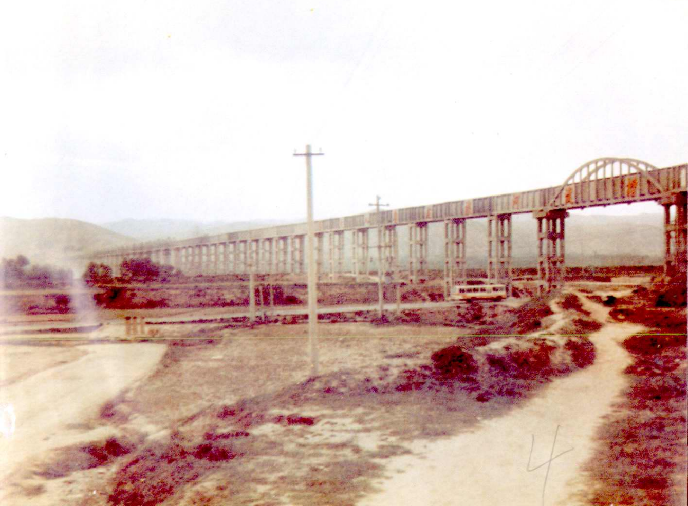
引大入秦东二千渠庄浪河大渡槽
