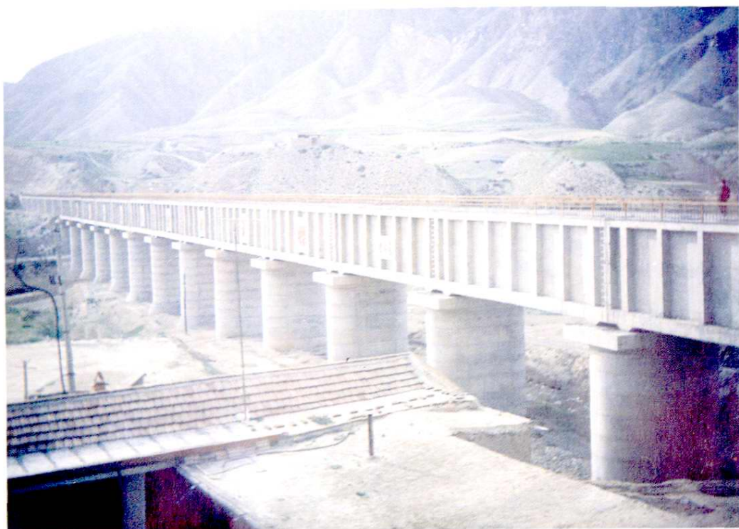
引大入秦总干渠大沙沟渡槽
