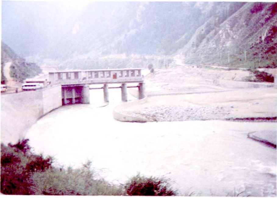
引大入秦总干渠渠首
