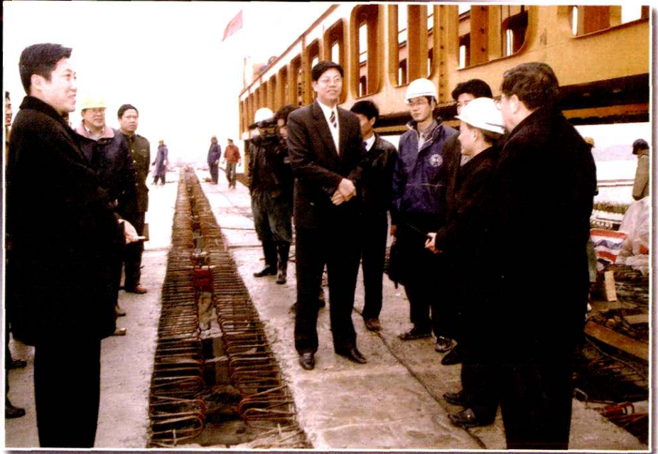
台州市、椒江区领导节日慰问椒江大桥工程技术人员和施工人员。
