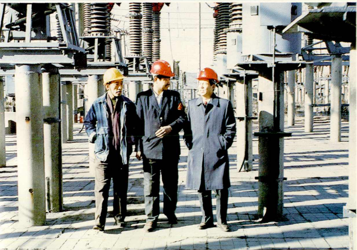
局领导在变电站检查工作
