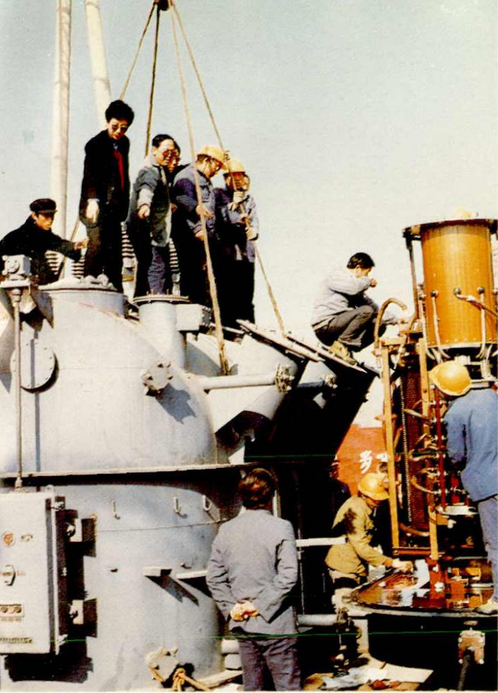
220 千伏长岭变电站主变吊芯检查
