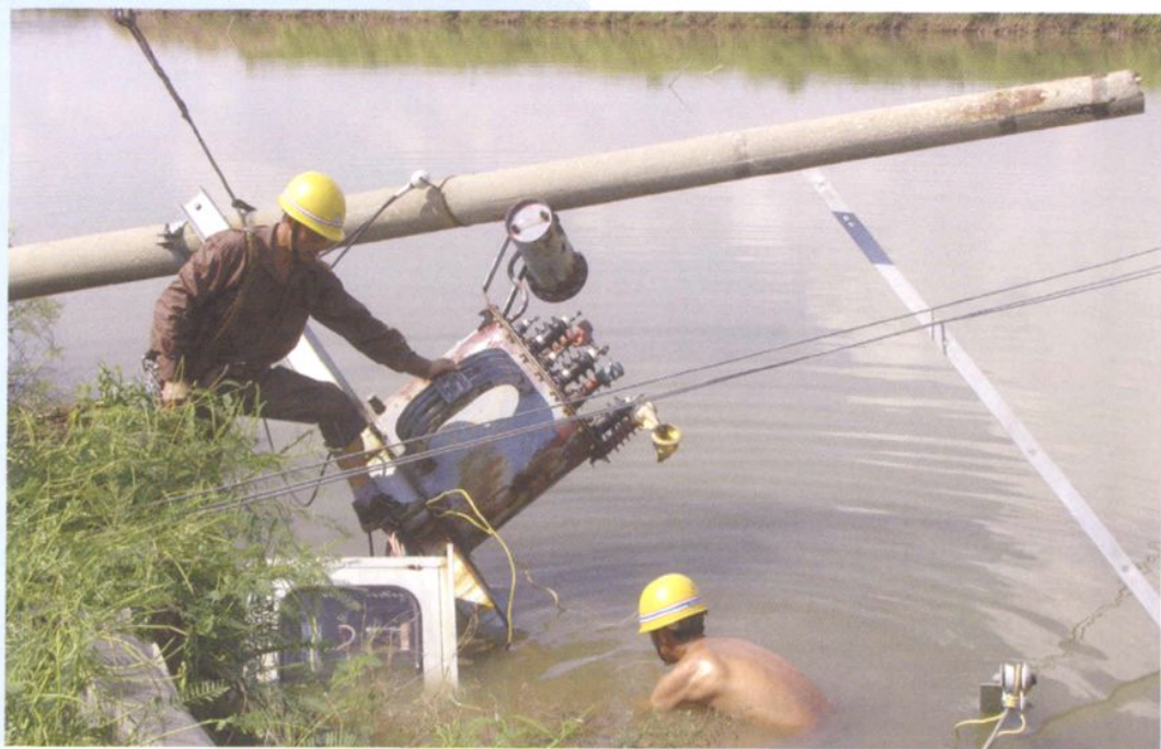
电力职工抗洪抢险救灾中抢修线路
