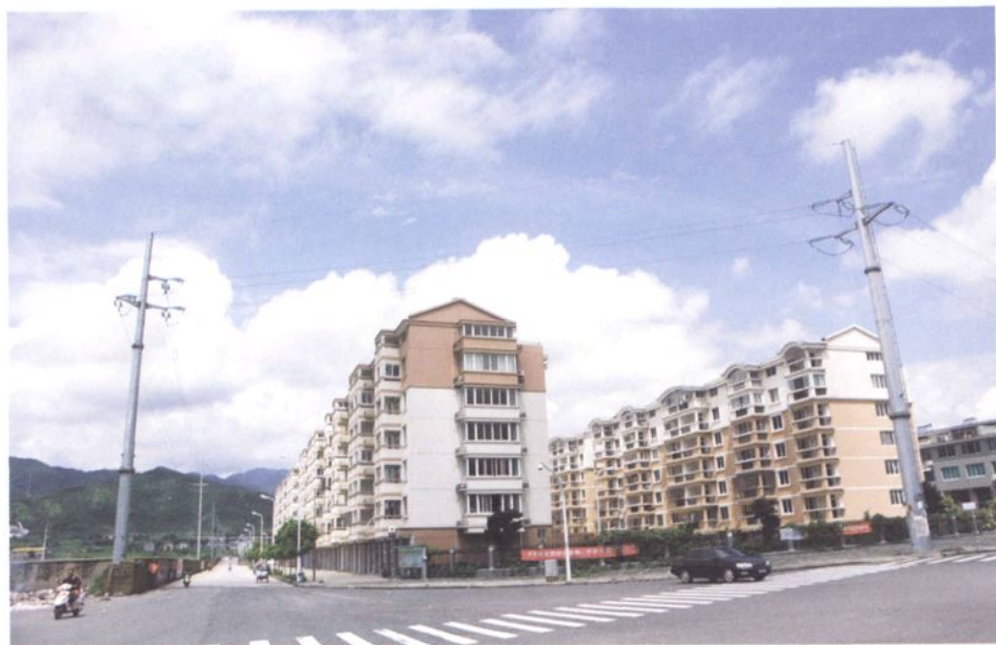
35 千伏钢管线路
