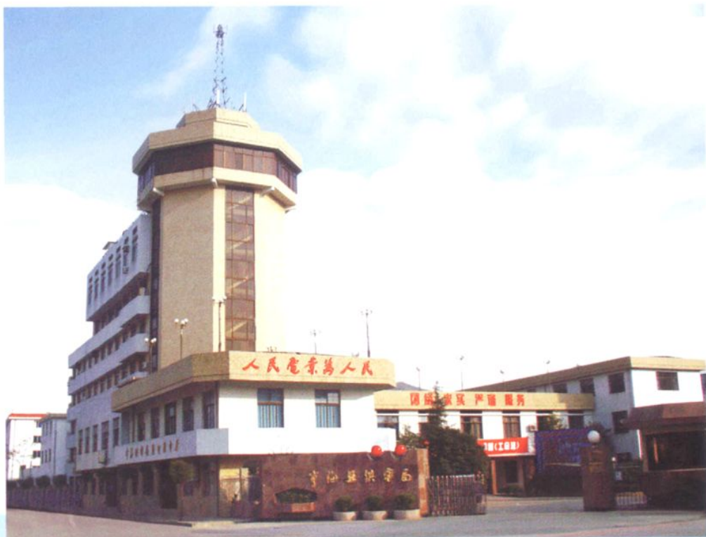
宁海县供电局大楼
