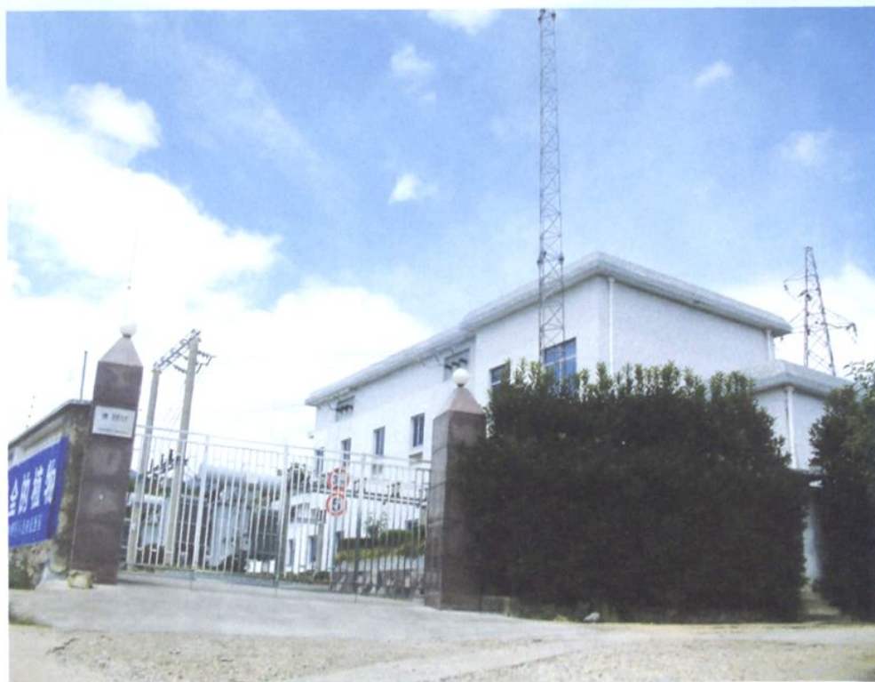
35 千伏黄坛变电所
