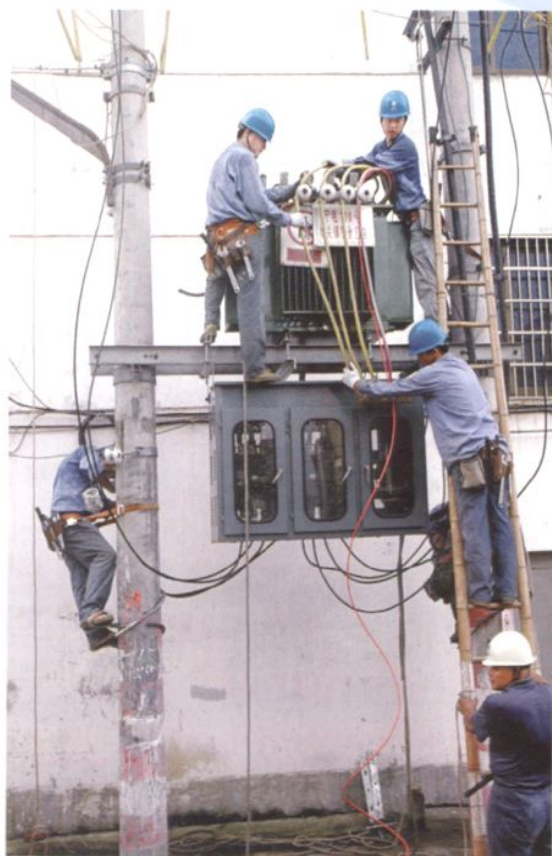
农村电网建设
