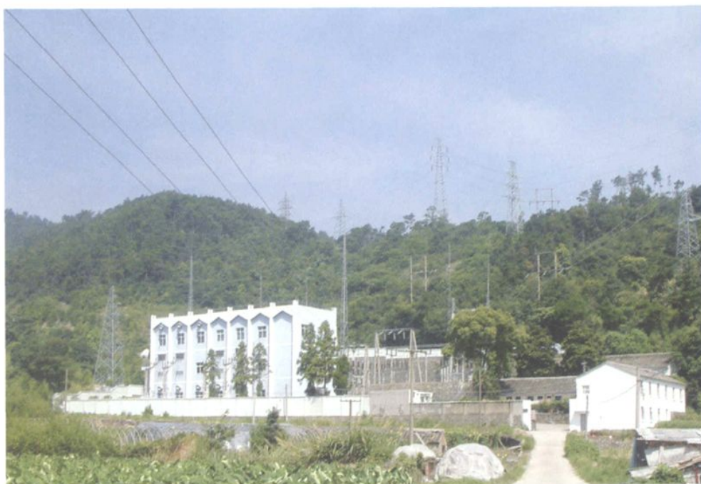
110 千伏梅林变电所
