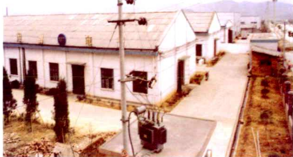
天马镇常桥村建于新都工业园区的标准厂房 徐生喜提供
