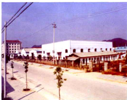
天马镇常桥村建于新都工业园区的标准厂房 徐生喜提供
