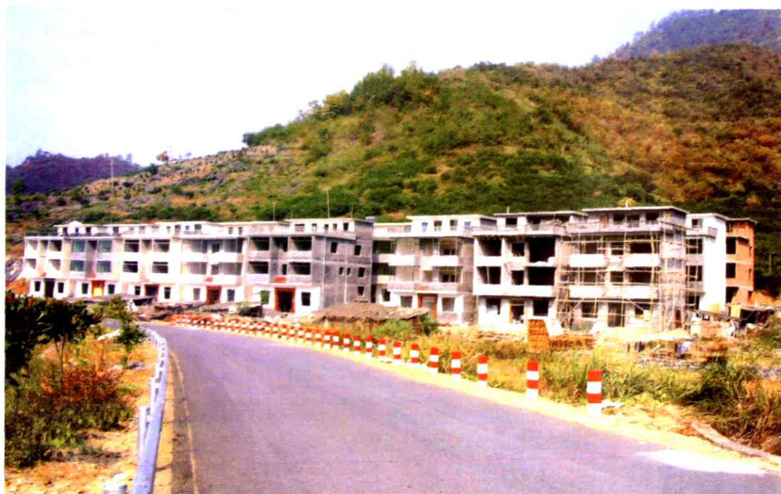
蜀阜后靠移民在淳安县威坪镇新建的“新蜀阜村”
